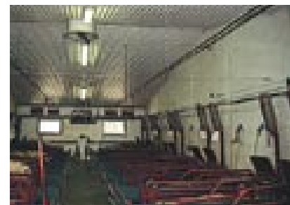
Lavtryk olieudsprøjtningssystem i farestald. Når røstregnen monteres over spaltegulvet, og dyserne monteres over stadskelelsen ved hveranden sti, vil eventuelle dryp ikke genere dyr eller mennesker.
