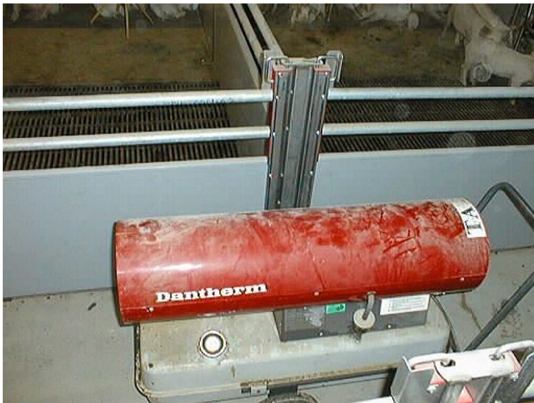
Udtørring med varmekanon
